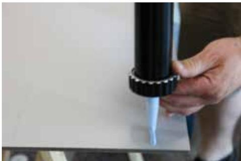
14. **Klebeverfahren A:** Das Streifenkleben mit Dreiecksraupen (8x9 mm), Vorteil: die Paneele bleibt hinterlüftet, ein Ausgleichen von leichten Unebenheiten ist möglich. Der Ausgleich mittels Raupe ist bis ca. 1,5 mm möglich. Verbrauch: 4 Kartuschen pro Platte oder 1 Beutel für 5-6 m<sup>2</sup>.
