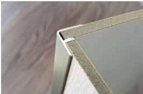
18b. **Eckprofil (Innen- und Außenecke), 2. Schritt:** Anschließend wird das zweite Board in das Eckprofil eingeschoben. Auf eine wasserdichte Ausführung von 17. und 18. muss geachtet werden. Überschüssiger Kleber muss umgehend von der Oberfläche entfernt werden.
