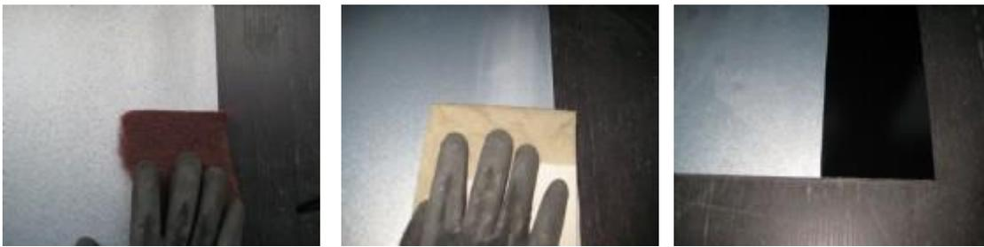
Im vierten Schritt wird die Fassadenplatte mit einem Schleifvlies oder Gitter angeschliffen. Anschließend wird die Fassadenplatte mit einem Zellstofftuch und mit Sika Aktivator 205 gereinigt. Danach wird Sika Tack Panel Primer aufgetragen und mind. 30 Min. max. 8 Std. abgelüftet.
